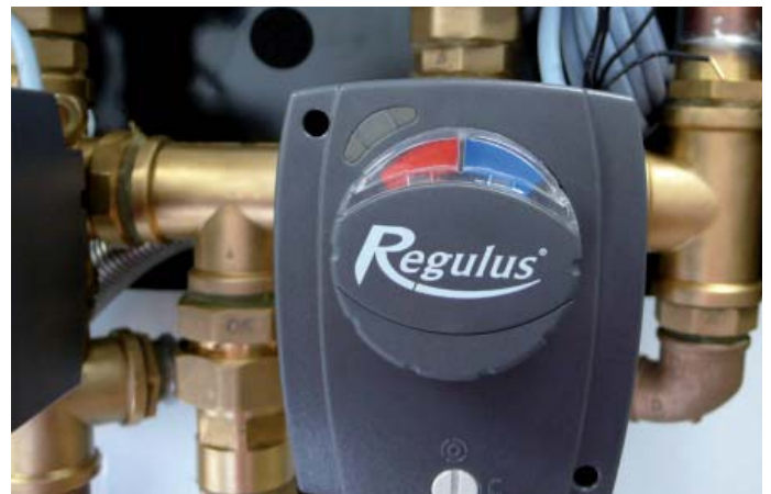
17. Pohon namontovať na pravý zmiešavací ventil.
